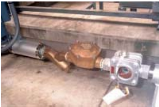
ポラー型式PI-32CF一式設置写真
