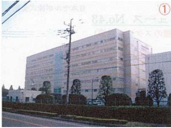
国内一流光学機械メーカーの半導体クリーンルームの工場です。 空調は大変重要な設備となっております。
