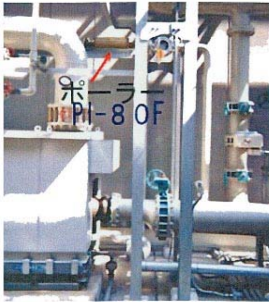
ポローラーを空調用500RT冷却水ラインに設置
