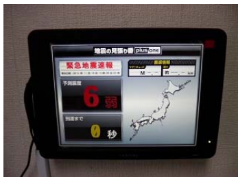
（緊急地震速報受信装置／震度6弱で起動）
